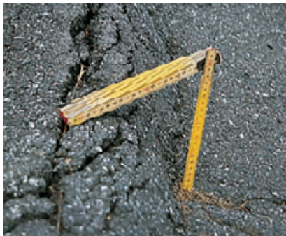
▲ Пример, показывающий последствия воздействия мороза на почву, что наносит большой урон дорогам, канализационным системам и домам.
